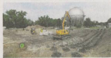
Hier stand mal ein Öltank, der vor einigen Wochen abgerissen wurde ...
