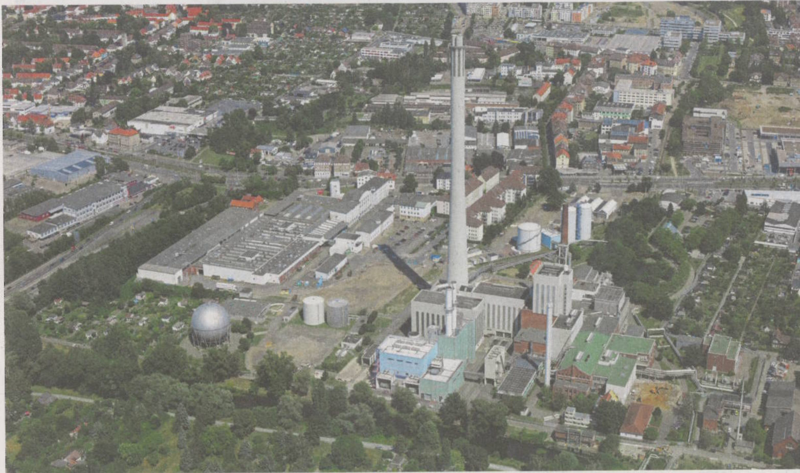
Blick auf das Heizkraftwerk Mitte aus westlicher Richtung. Gut zu erkennen sind die Baufelder, die für die neuen Anlagen vorbereitet wurden, zum Beispiel links vom Schornstein. Am unteren Bildrand fließt die Oker zwischen den Bäumen.
